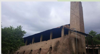
Antiga Fábrica de Cerâmica 陶器工場の廃墟。 インドネシア占領時代にXanana が隠れた場所だそう。
