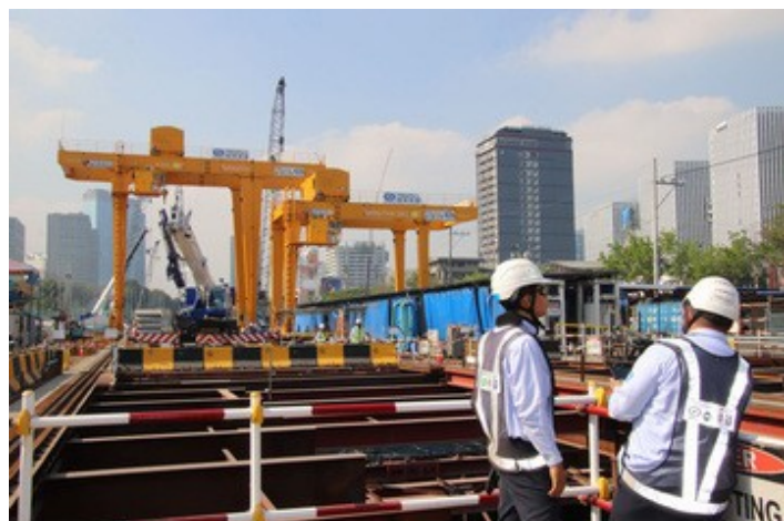
マニラ地下鉄の工事現場＝3 月、ケソン市（NNA 撮影）
