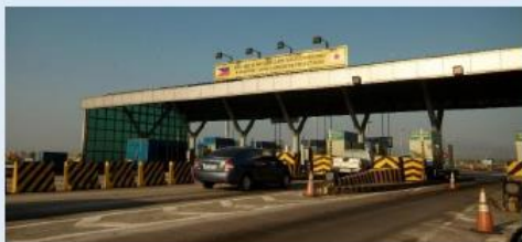
メトロマニラ立体交差
