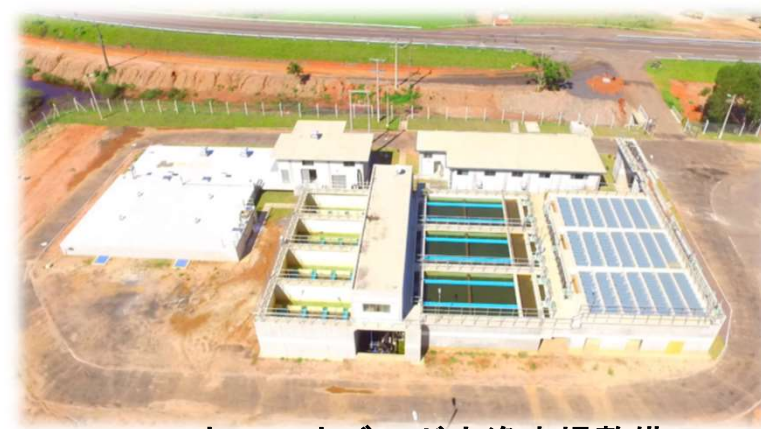
コロネル・オビエド市浄水場整備
