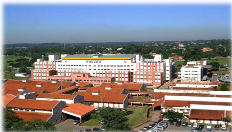
アスンシオン大学病院建設・整備
