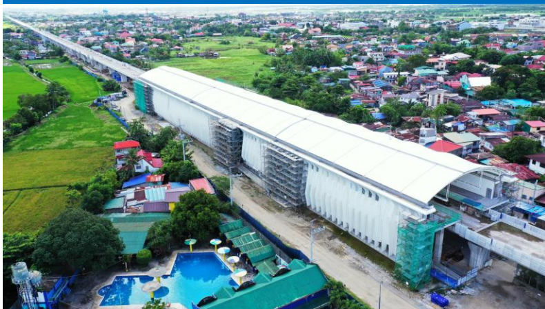
南北通勤鉄道 建設中の駅の様子
