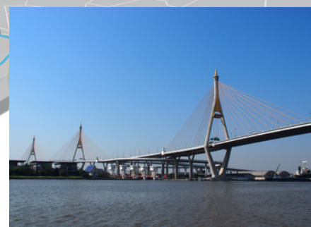
チャオプラヤ川にかかる 14の橋の建設・補修
