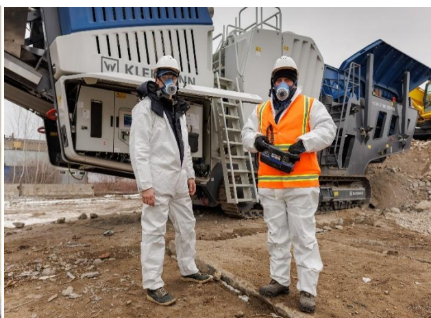
瓦礫処理現場
