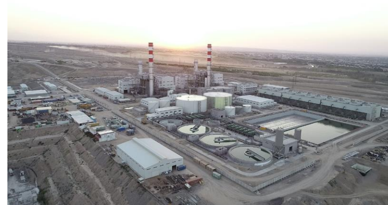
トラクルガン火力発電所 完工後（2019年）
