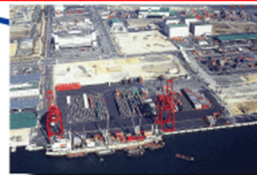
●六甲アイランド地区：仮設橋樑埠頭工事 神戸港の復興コンテナ貨物の取扱いは早急に回復する
