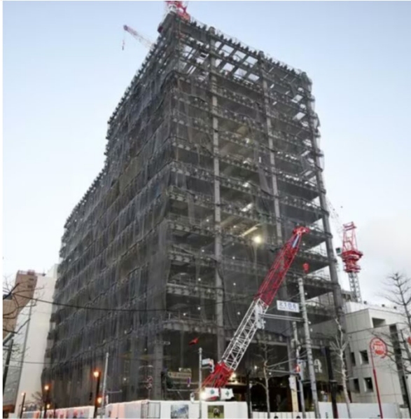
札幌市で建築中の高層ビルで精度不良などが発覚した。組み上がった鉄骨を解体して建て直す異例の事態に（写真：共同）
