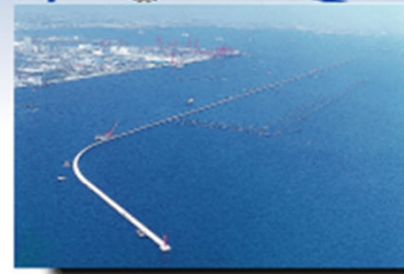
●防波堤：第7防波堤復旧工事 防波堤は地震の影響により躯体が最大2mもの沈下が生じ
