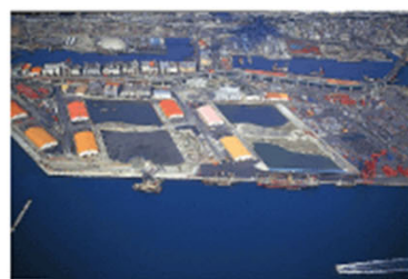
●摩耶地区：岸壁（-12m）等築造工事 摩耶埠頭南側の岸壁にはケーソンタイプの重力式構造と鋼管杭による橋脚構造が採用された。本工程区域はケーソンタイプの構造が採用されている。工事は摩耶2突～3突間前出の岸壁2バースが完成し、残りは平成9年2月末に完成する予定。
