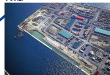
●六甲アイランド地区：岸壁-12m②外復旧工事 スリップに面する当岸壁は前面の水域を確保する必要があるため、ケーソン面直し工法が採用された。岸壁の復旧は既に2バースが完成しており、残りの岸壁も9年3月末に完成する予定。
