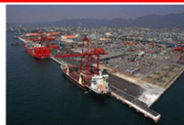
●摩耶地区：岸壁-12m②外復旧工事 摩耶埠頭南側の岸壁にはケーソンタイプの重力式構造と鋼管杭による橋脚構造が採用された。本工程区域は鋼管杭による橋脚構造が採用されている。復旧工事は3月末に完了し、供用されている。
