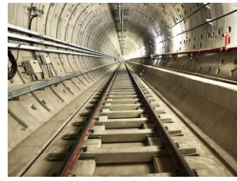
地下トンネル
