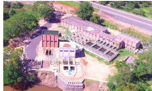
Toma de Agua cruda - Tebicuary mi
