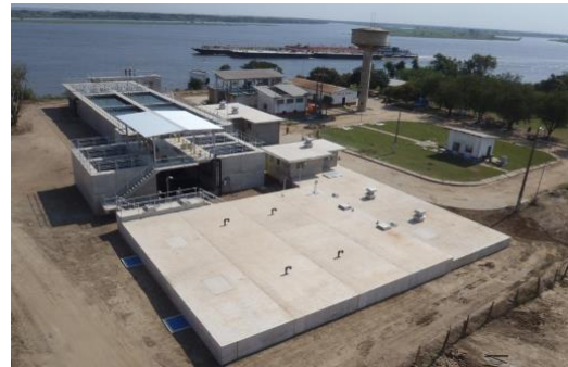
Planta de Tratamiento - Pilar
