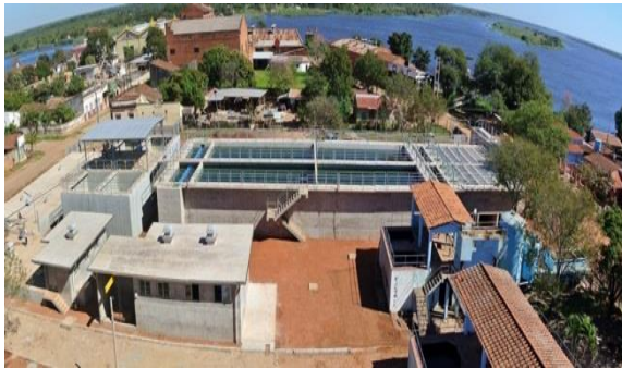
Planta de Tratamiento - Concepción
