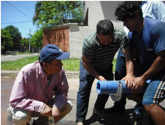
Renovación de tuberías
