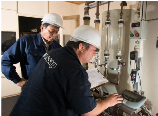
Verificación de medidores
