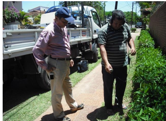
Detección de fuga de agua
