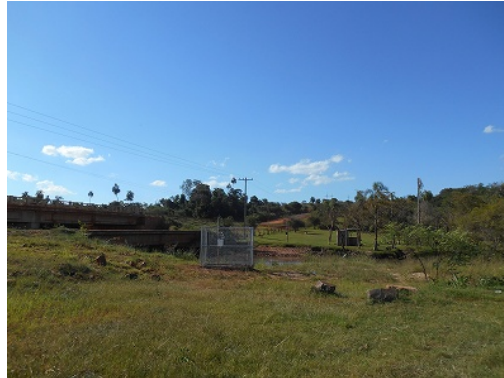
Foto 4.149 Estado del medidor instalado (7)
