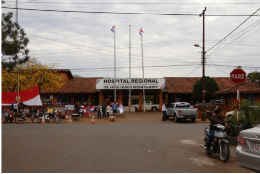
日本の無償資金協力で建設されたアマンバイ地域病院 ¥
