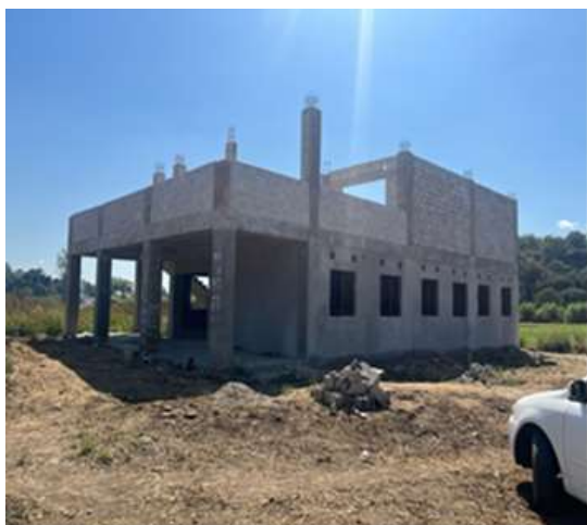
建設中の中高等学校(一部)
