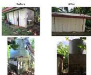
改修したトイレとレインタンク
