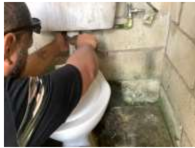
トイレ洗浄タンク修繕指導
