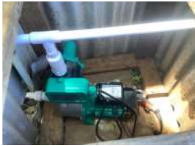
送水ポンプの設置完了
