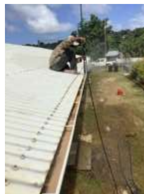
屋根と雨樋の洗浄作業
