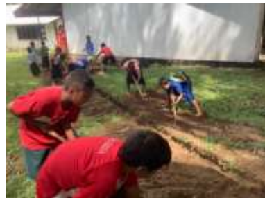
子供たちが参加したポンプ用配線の敷設作業
