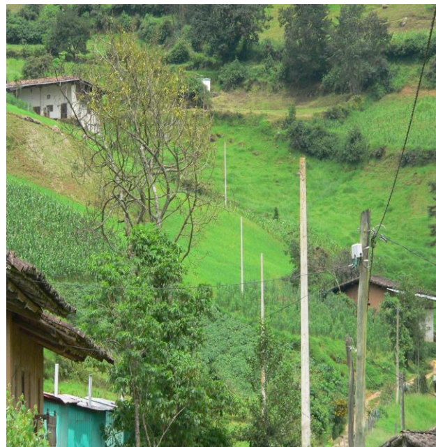
Instalación de Postes Eléctricos en Zonas Rurales de Cajamarca
