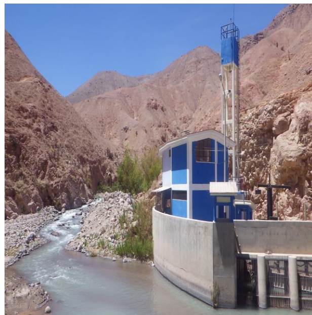
Captación de agua de la futura CCHH Moquegua 1
