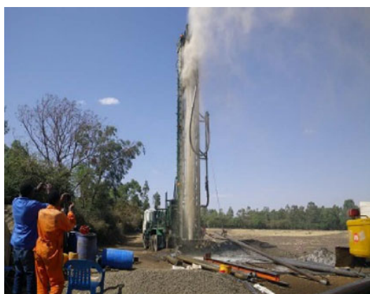
気候変動に対して強靱な水資源である地下水開発の様子
