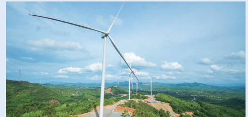
稼働する風力発電(写真:株式会社レノバ)
