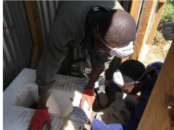
トイレの設置
