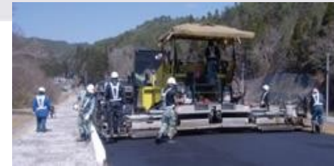
再生アスファルトを活用した舗装
