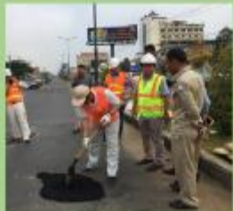
常温合材を用いたポットホール補修（穴埋め、切削）を指導
