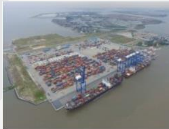
ベトナム・ラックフェン港
