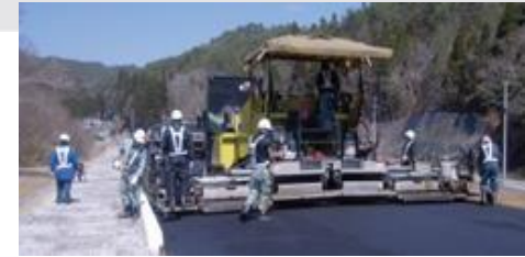
再生アスファルトを活用した舗装
