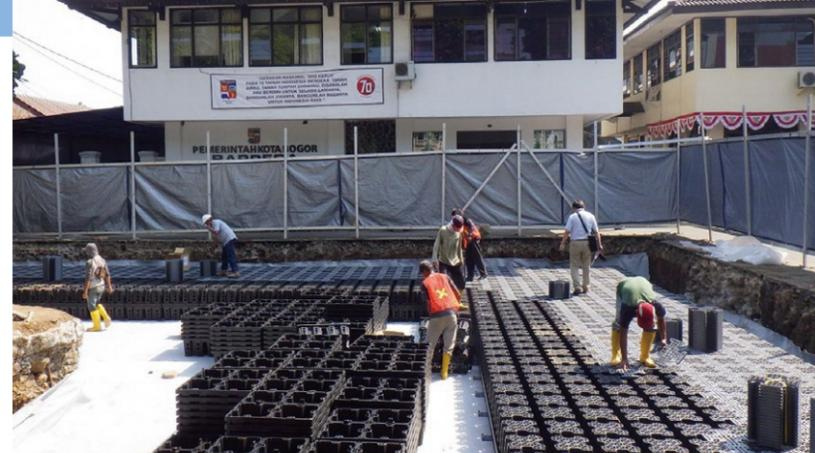
秩父ケミカルでは2015年9月、インドネシア・ボゴール市の公共施設の駐車場に、プラスチック製雨水貯留浸透施設を設置した。写真はプラスチック製雨水貯留槽(ブラダムくん)の設置風景
