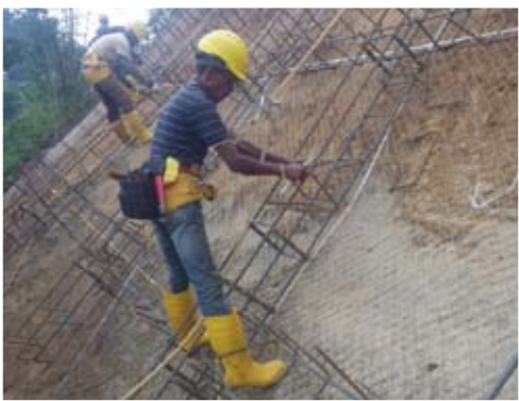
傾斜地にユニット式金網型柵を設置する現地スタッフ。今回の事業では技術適用調査のほか、セミナーや設計・施工マニュアルの紹介なども行われている
