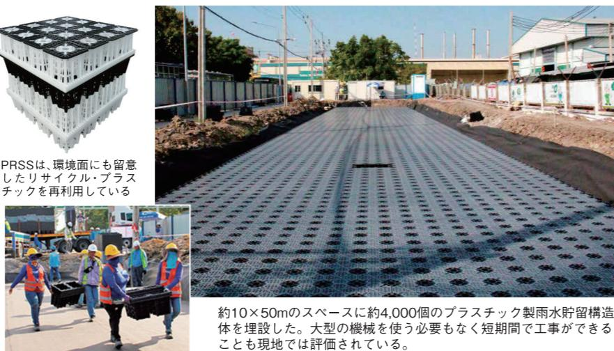
約10×50mのスペースに約4,000個のプラスチック製雨水貯留構造体を埋設した。大型の機械を使う必要もなく短期間で工事ができるこも現地では評価されている。
