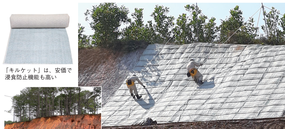
粘土質の赤土がむき出しのまま放置され、雨水で浸食された現場。「キルケット」はこうしたのり面の崩壊抑制に効果を発揮する
