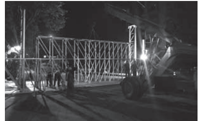
情報板ガントリーの設置
