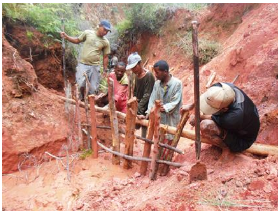
3 ème étape : Formation technique sur la stabilisation de lavaka
