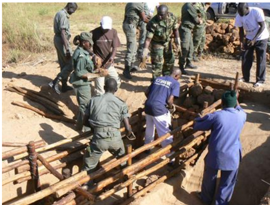
Formation des formateurs sur la diguette en cadre pour lutter contre l'érosion (PRODEFI)
