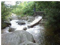
修復された取水堰
