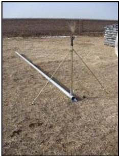
(スプリンクラーの設置状況)
