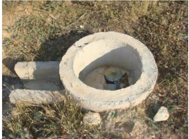
給水栓からの用水を土水路に導くための円筒型静水柵+導水口
