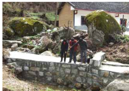
完工后的取水堰（2012年3月）
