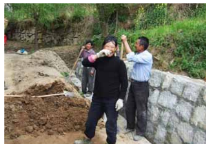
由村民亲手修复的渠系工程
