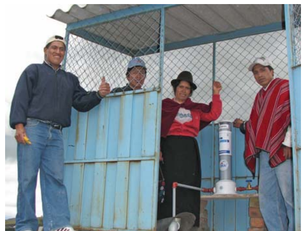
塩素水質浄化装置の設置
