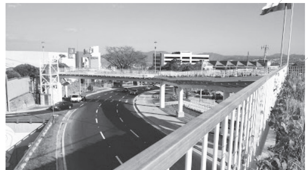
Pasarela del Redondel Masferrer, San Salvador.
