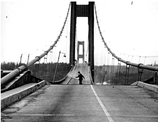
La oscilación que destruyó el puente Tacoma Narrows en 1940, se puede estudiar utilizando trigonometría.
