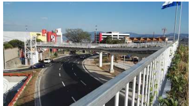
Pasarela del Redondel Masferrer, San Salvador.
