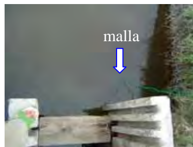
Entrada de agua
