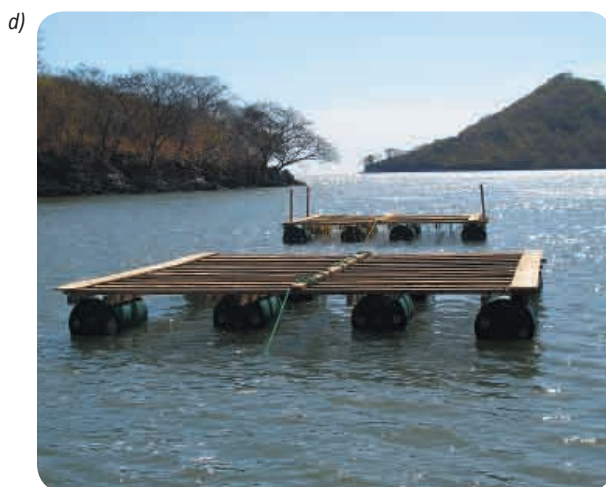
Fig. 17 Construcción e instalación de balsa en Isla Zacatillo, Golfo de Fonseca, La Unión. a) Construcción de la plataforma de madera de pino de 5x5m, b) Amarre de los barriles plásticos a la plataforma utilizando cuerda de nylon de 1/4", c) traslado de la balsa hasta su sitio de anclaje, d) Anclaje de la balsa. La balsa tiene capacidad para 100 linternas.,
