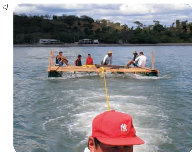
Fig. 17 Construcción e instalación de balsa en Isla Zacatillo, Golfo de Fonseca, La Unión. a) Construcción de la plataforma de madera de pino de 5x5m, b) Amarre de los barriles plásticos a la plataforma utilizando cuerda de nylon de 1/4", c) traslado de la balsa hasta su sitio de anclaje, d) Anclaje de la balsa. La balsa tiene capacidad para 100 linternas.,
