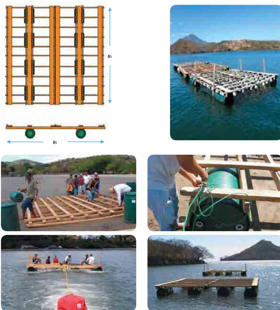
Fig. 3. Construcción e instalación de balsa flotante en Isla Zacatillo.
