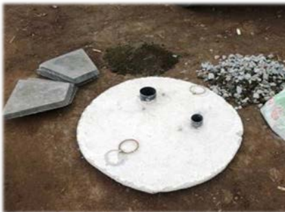
3. የግንባታ፣ የፓምፕና የተጓዳኝ መስሪያ ዕቃዎች ዝግጅት
