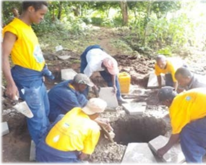
5. የአፕሮን ግንባታ፣ ፊዲዩሰር ብሎኮችን ማስቀመጥ እና የውሃ ማስኬጃ ቦይ ግንባታዎችን ማድረግ።
