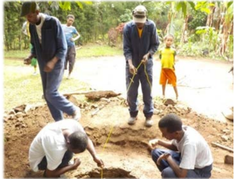
2. የጉድጓዱን ጥልቀት ማወቅ የውሃ መጠን ልኬት እና የጉድጓዱን አካባቢ የማየት ሂደት
