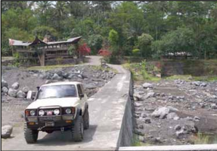
BANGUNAN SABO UNTUK JALAN PENYEBERANGAN
