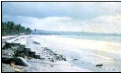
TEMBOK PANTAI DARI BETON
