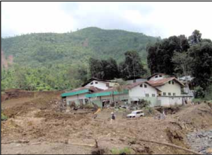
PERUMAHAN KOMPLEK PABRIK KOPI YANG TERKENA SEDIMEN TANAH HASIL EROSI DARI ALIRAN BANJIR BANDANG TANGGAL 2 JANUARI 2006 DI DESA GUNUNG PASANG KABUPATEN JEMBER
