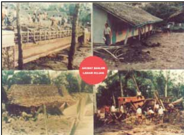
KERUSAKAN AKIBAT BANJIR LAHAR GUNUNG MERAPI
