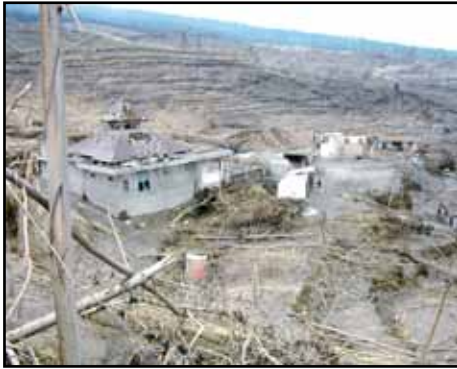
MESJID DAN RUMAH ALM. M. BAH MARIJAN YANG TERKENA DIRECT BLAST (SEMBURAN LANGSUNG) YANG MENGANDUNG GAS DENGAN KECEPATAN KURANG LEBIH 300 KM/ JAM
