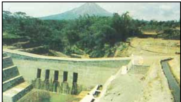
BANGUNAN SABO UNTUK IRIGASI
