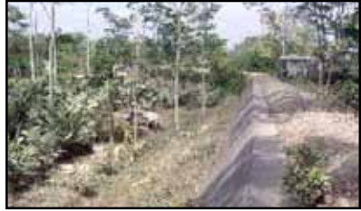
TANGGUL TANAH DIPERKUAT DENGAN PASANGAN BATU
