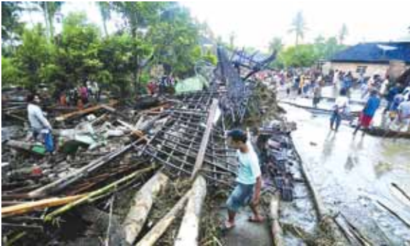
KERUSAKAN RUMAH YANG DIAKIBATKAN BANJIR BANDANG
