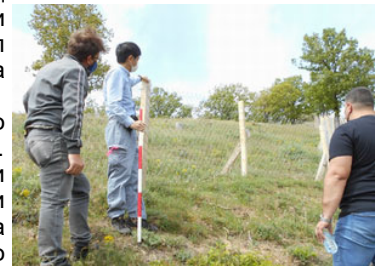
Контрола на заштитната ограда
