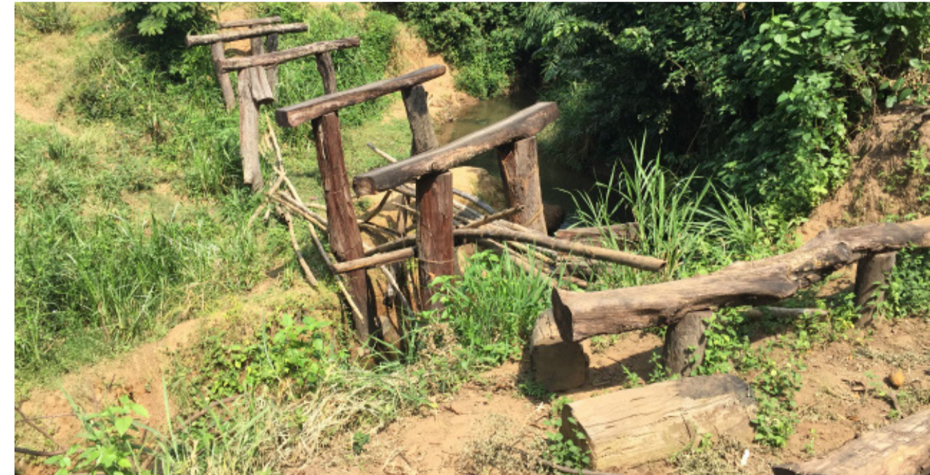
Ujenzi wa daraja la kijiji ukiendelea.
