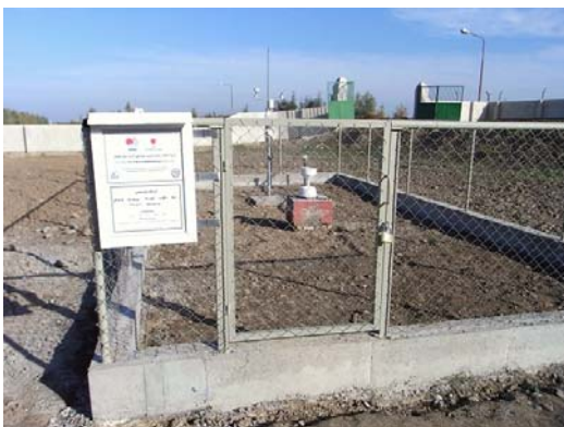
عکس: ایستگاه هواشناسی؛ فنس کشی شده، تابلوی نصب شده بر روی در ورودی شامل علامت ODA و معرفی ایستگاه
