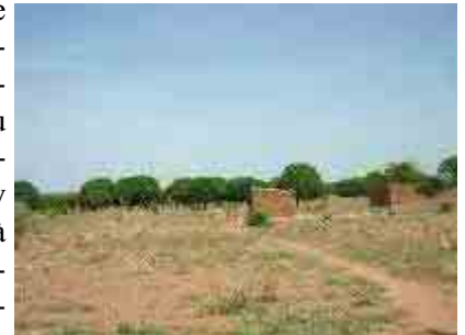
Site de construction du centre de formation
