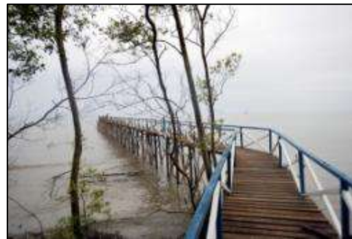
写真 1. 海岸から作業小屋手前まで約 1,000m の木道を建設した。赤い屋根の小屋は船着場であるが、干潮時にも上陸できるよう、木道を約 80m 海側に伸ばした。
