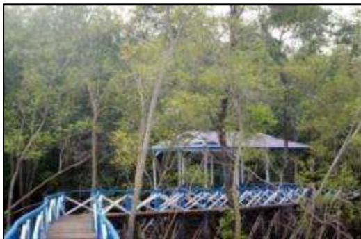
写真 1. 海岸から作業小屋手前まで約 1,000m の木道を建設した。赤い屋根の小屋は船着場であるが、干潮時にも上陸できるよう、木道を約 80m 海側に伸ばした。
