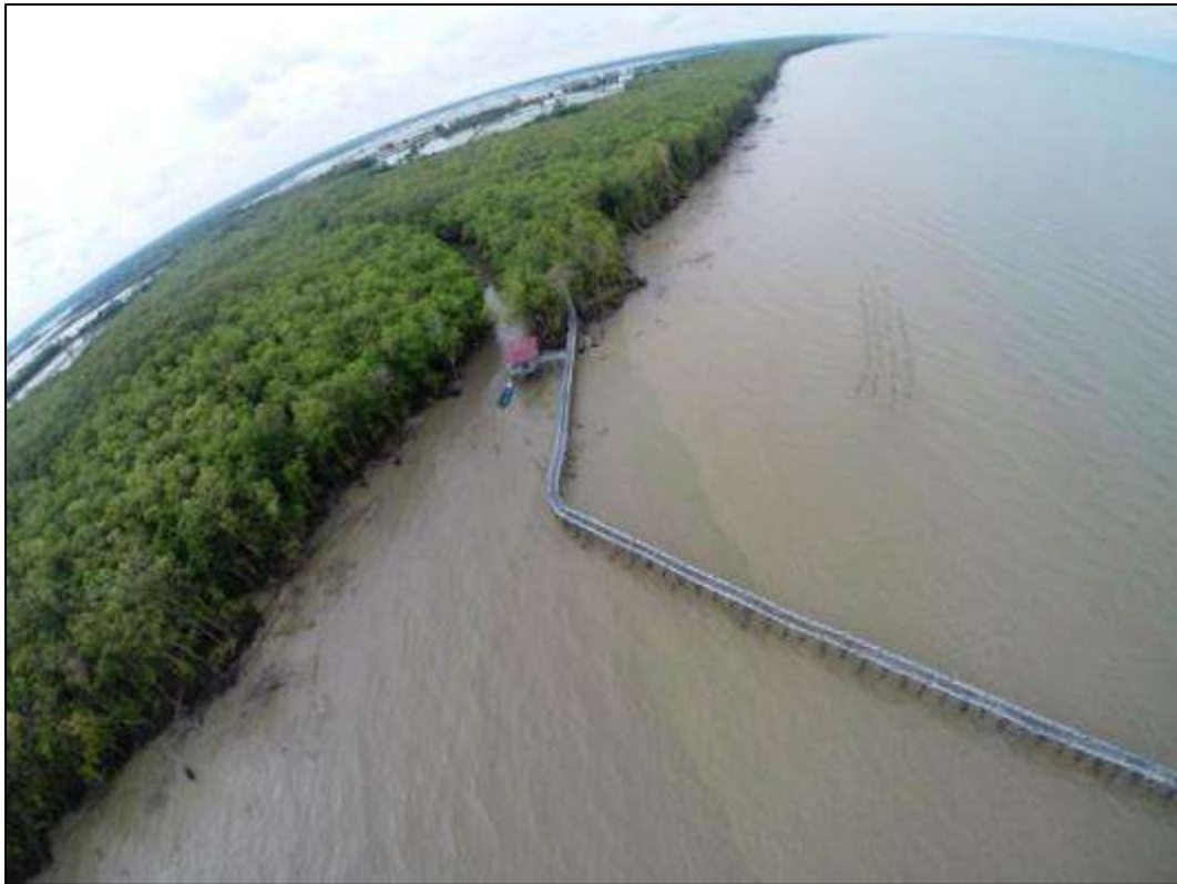
写真 1. 海岸から作業小屋手前まで約 1,000m の木道を建設した。赤い屋根の小屋は船着場であるが、干潮時にも上陸できるよう、木道を約 80m 海側に伸ばした。
