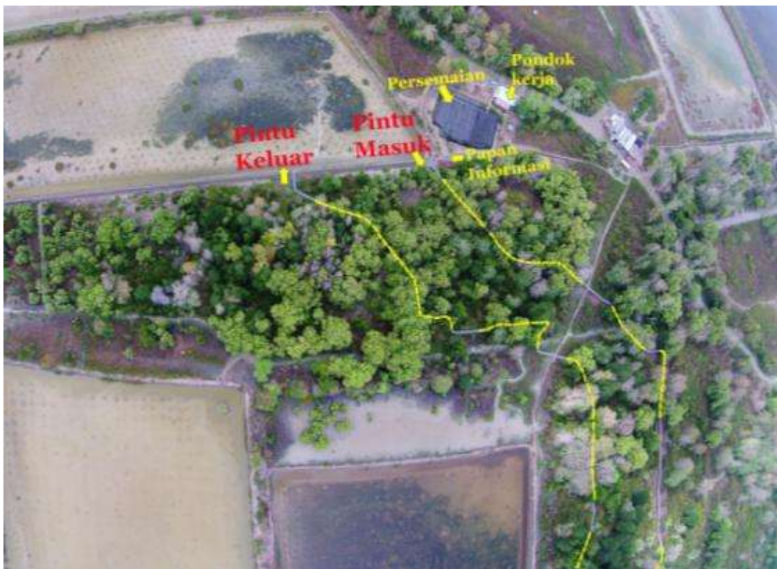
写真 1. マングローブ・トレイルの全景。黄色い波線が木道。右が入り口、左が出口。 入り口わきに説明版を設置している。白い屋根が作業小屋、黒い屋根が苗畑。
