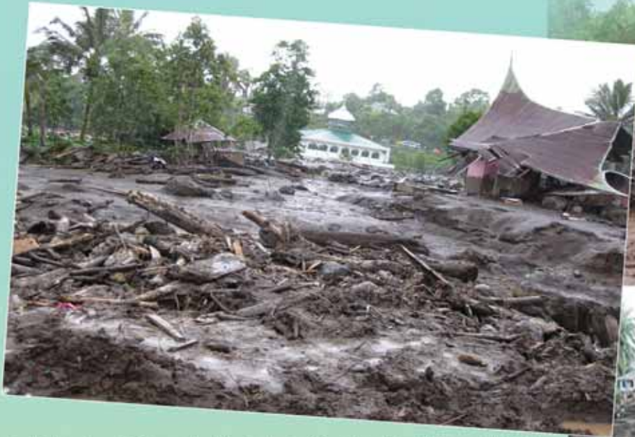
Foto banjir bandang di Kabupaten Tanah Datar, Sumatera Barat, 30 maret 2009 merusak infrastruktur, masjid, pusat perbelanjaan, dan rumah warga.
