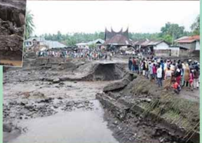
Foto aliran debris ( debris flow ) banjir bandang yang merusak jembatan penyebrangan dan infrastruktur lainnya.
