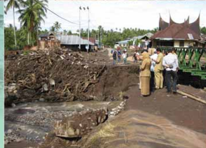
Foto banjir badang telah merusak jembatan penyebrangan, dan dengan bantuan TNI, telah dibuat jembatan darurat (warna hijau).
