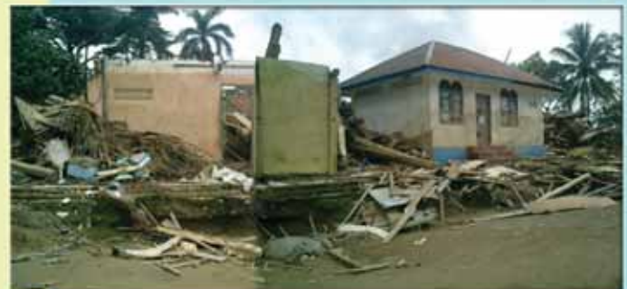
Foto kerusakan bangunan akibat banjir bandang di Bohorok, Sumatera Utara Nopember 2003
