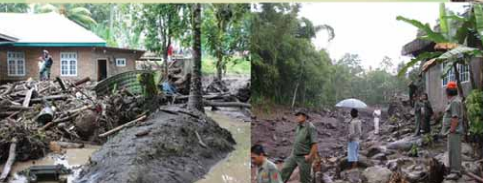
Foto kerusakan bagian bawah rumah warga akibat terjangan banjir bandang.
