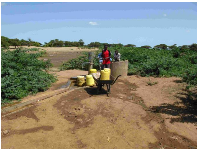
水源施設における水位水質の事前調査（トゥルカナ県） Kakuma周辺の水源用地下ダムと浅井戸用ハンドポンプの 様子。20L入りのジェリカンで給水している。
